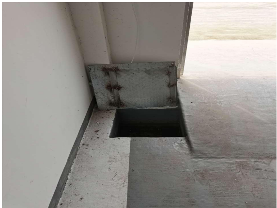
渗滤液收集池
