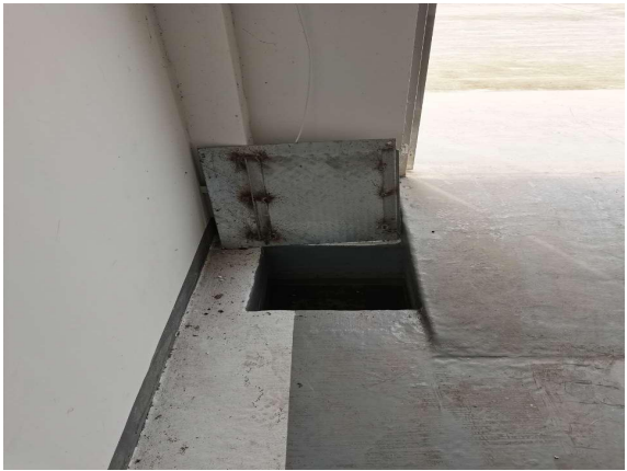
渗滤液收集池
