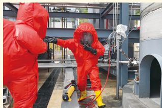
公司应急救援队堵漏抢险作业。吴林婷摄
